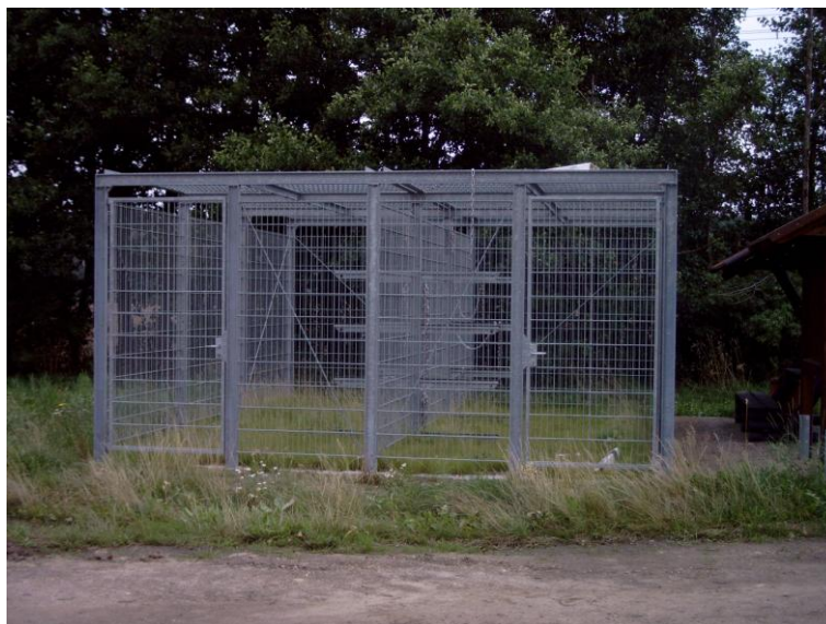
Abb . 56: Abschließbarer Kanukäfig zur sicheren Aufbewahrung der Boote.
