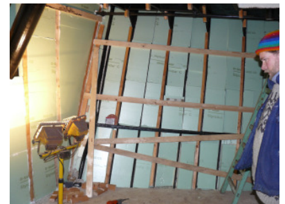
Fußboden und Wandisolierung
