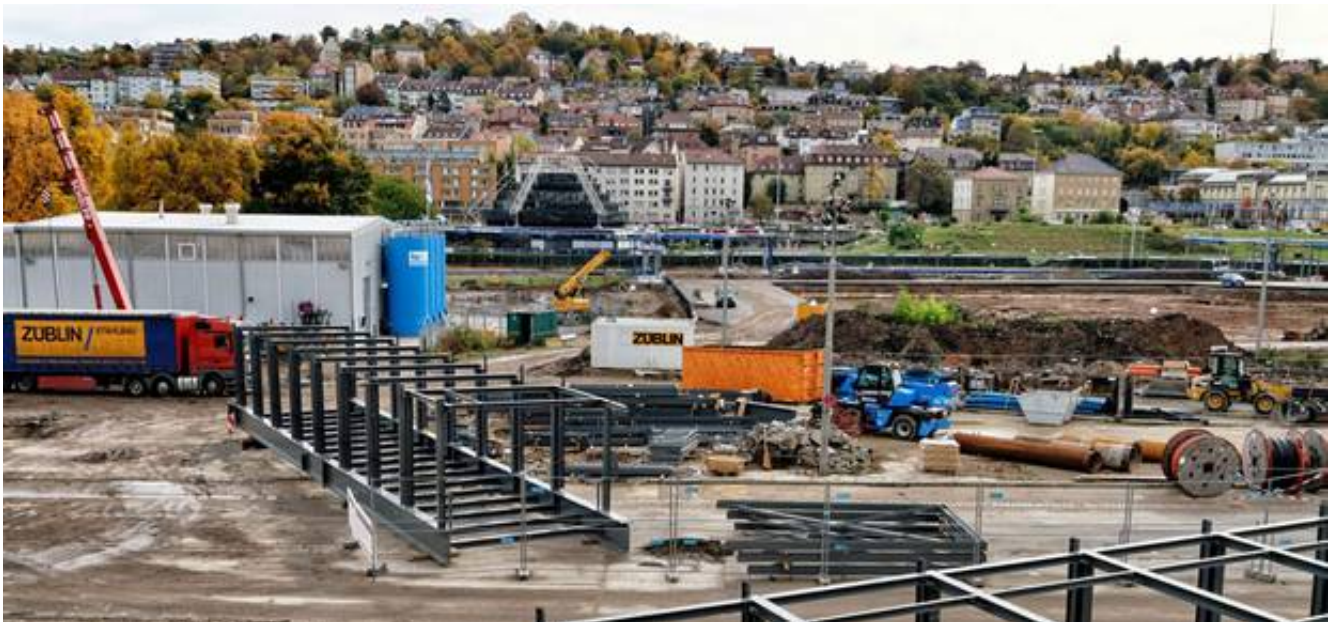
S21-Baustelle Stuttgarter Schlossgarten. Foto: Martin Storz
