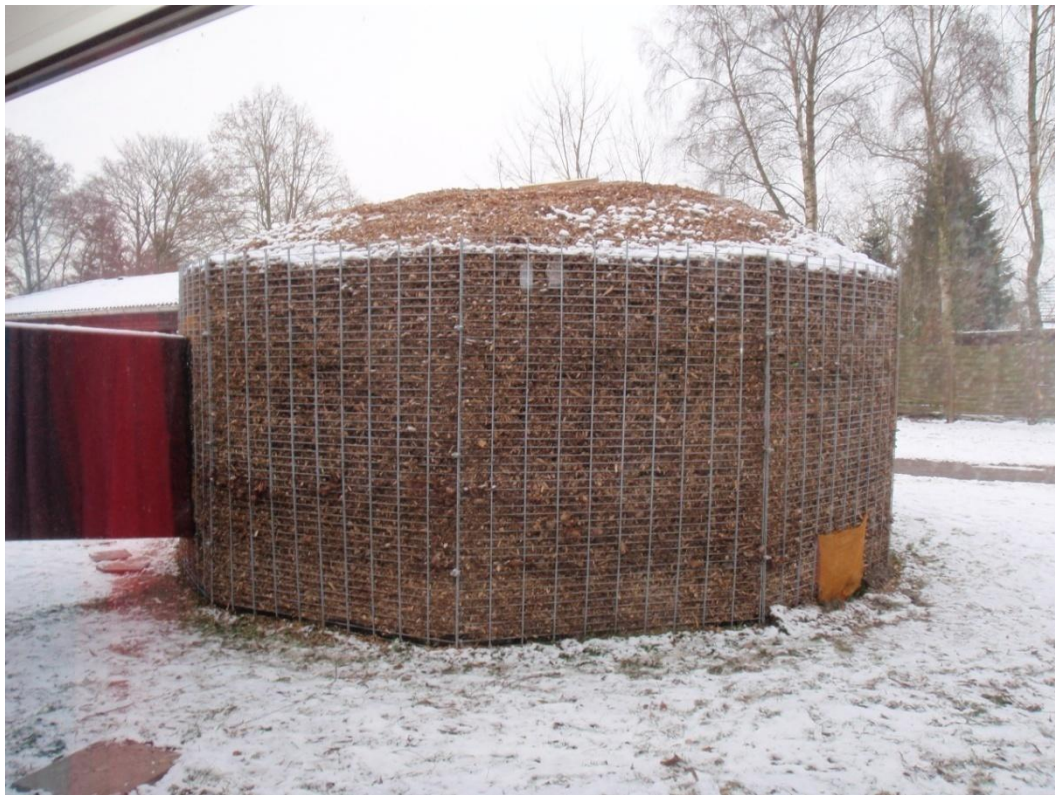
Der neue Biomeiler an der Schule. Hier wird Wärme durch bakterielle Zersetzung des frischen Holzschredders erzeugt
