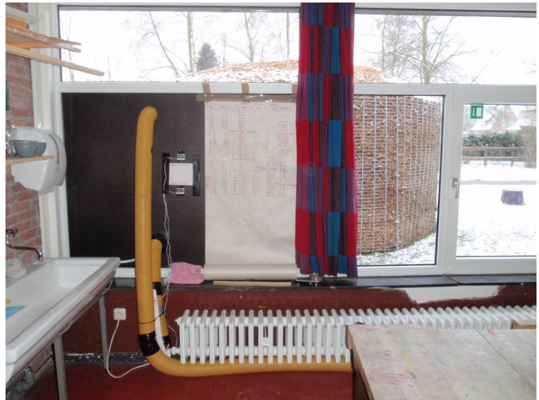
Die Wärme aus dem Biomeiler wird über Rohre ins Klassenzimmer geführt
