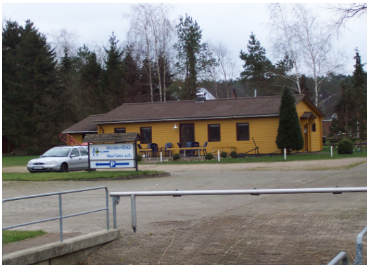
Bootshaus in Elm, An der Oste 20a
