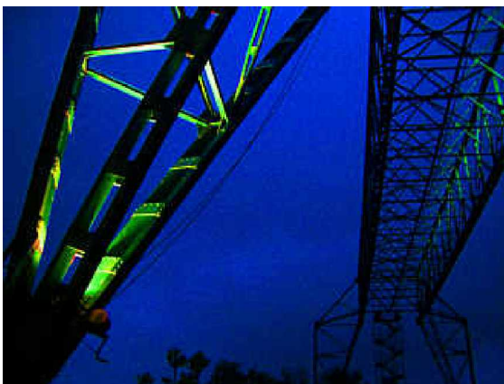
Beleuchtungsprobe in Osten (Mai 2005)
